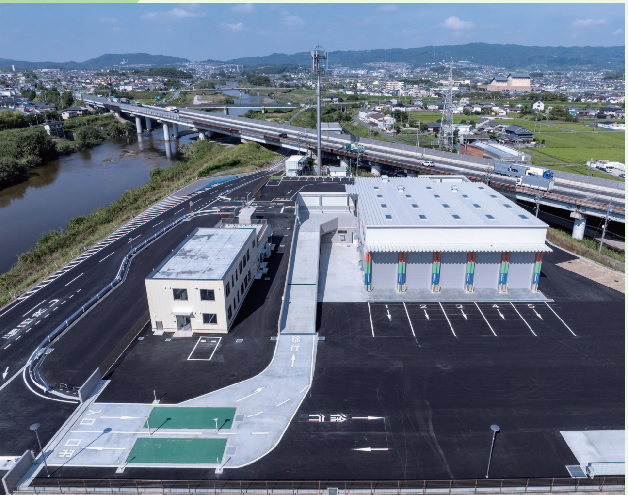
まほろば廃棄物運搬中継施設
